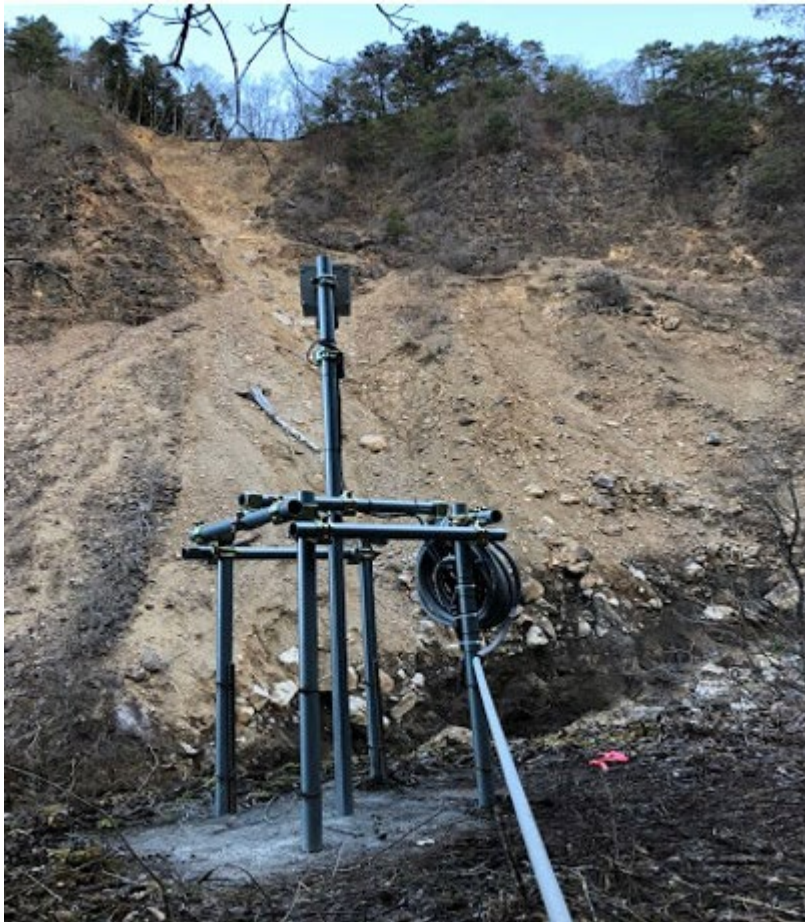
カメラ設置状況
