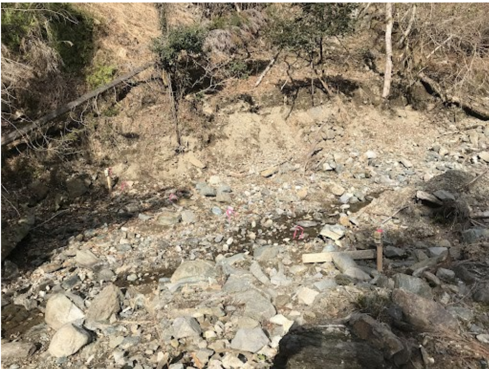
子機設置事例 2
